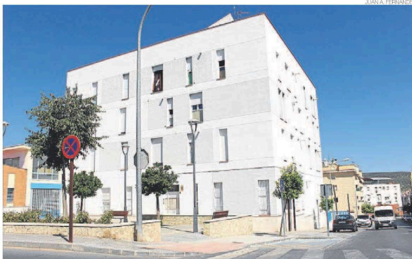
▶ Viviendas de Suvilusa en régimen de alquiler en la calle Federico García Lorca.
